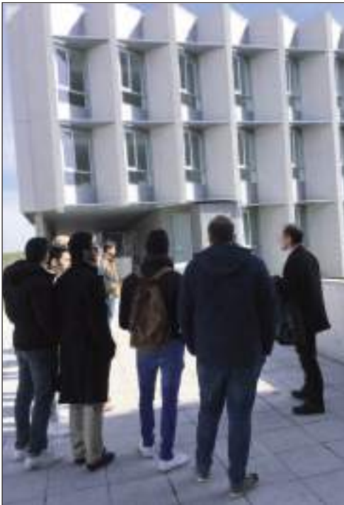
Foto 3: Efecto dentado en el diseño de huecos para reorientar los huecos en fachadas Norte-Este y Sur-Oeste.
